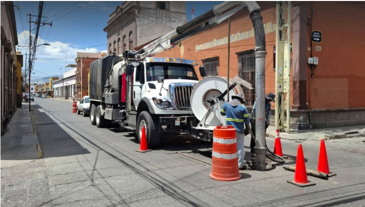
ACCIONES. Se refuerza desazolve de drenajes, limpieza de rejillas y alcantarillas.
