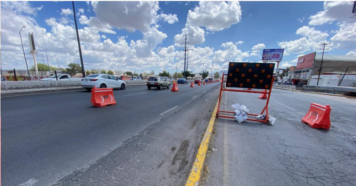
POR OBRA. Se reduce carril en Salvador Nava.
