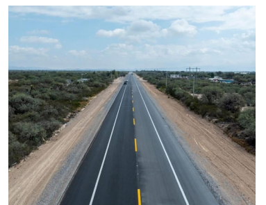
ATENCIÓN. Se han rehabilitado caminos estratégicos.
