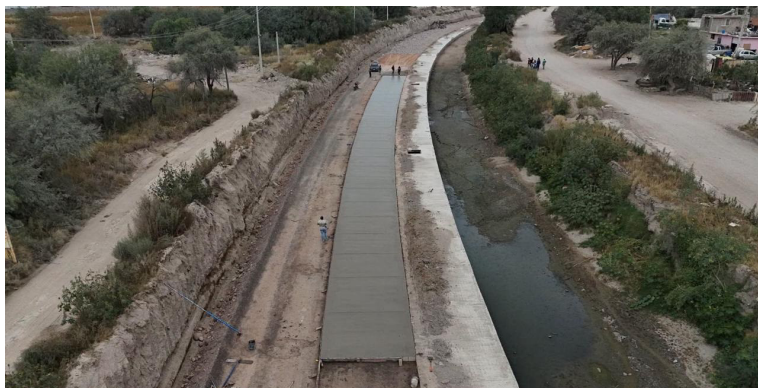
PRIMER KILÓMETRO. Comenzó el colado de la vialidad que conectará SLP con SGS.
