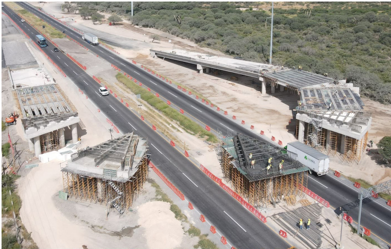
OBRA. Se realiza el montaje de traveses en entronques Peyote y Villa de Arista.
