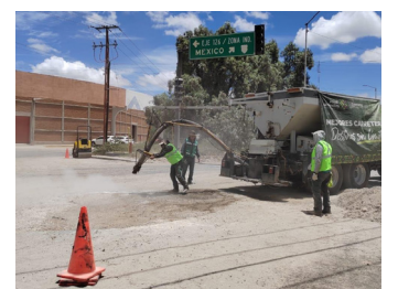
REPARACIÓN. Se da mantenimiento a las principales arterias vehiculares.
