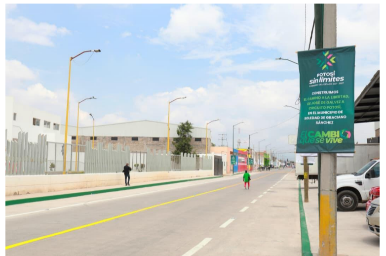
MEJORA. La obra incluyó la pavimentación con concreto hidráulico.
