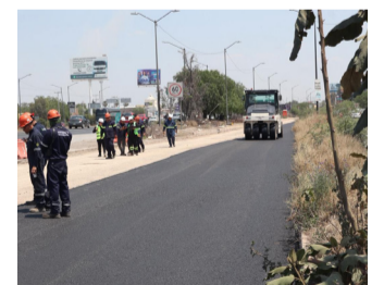
EN MARCHA. Las obras beneficiarán a habitantes y trabajadores de la zona.
